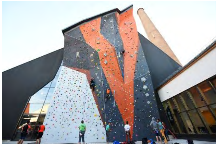
Le Climbing Mulhouse Center à deux pas du bâtiment 62
